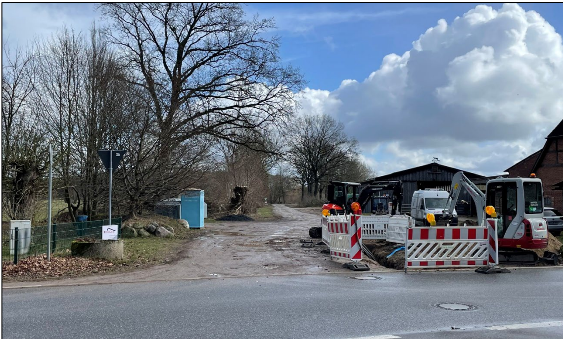
Abb. 18: Straßenansicht der Fläche 2 (rechts) vom Standort Gudower Straße (Hs-Nr. 2) in östliche Richtung blickend (PROKOM Stadtplaner und Ingenieure GmbH)
