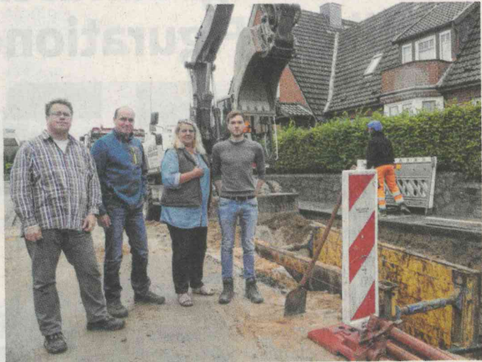
Bürgermeisterin Cornelia Wagnitz besichtigte mit Dirk Völkering (GSP/li.), Guido Steinhagen (ASA-Bau) und Lars Fischer (Storm-Bürau) die Bauarbeiten.
